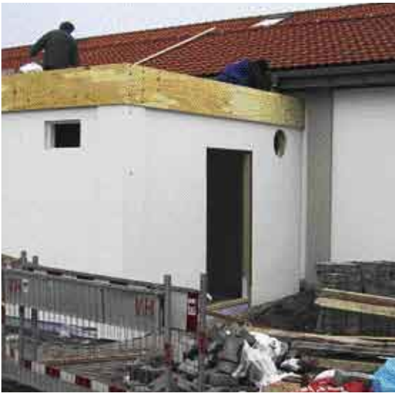
Die Montage des Holzbaus dauerte lediglich zwei Tage
